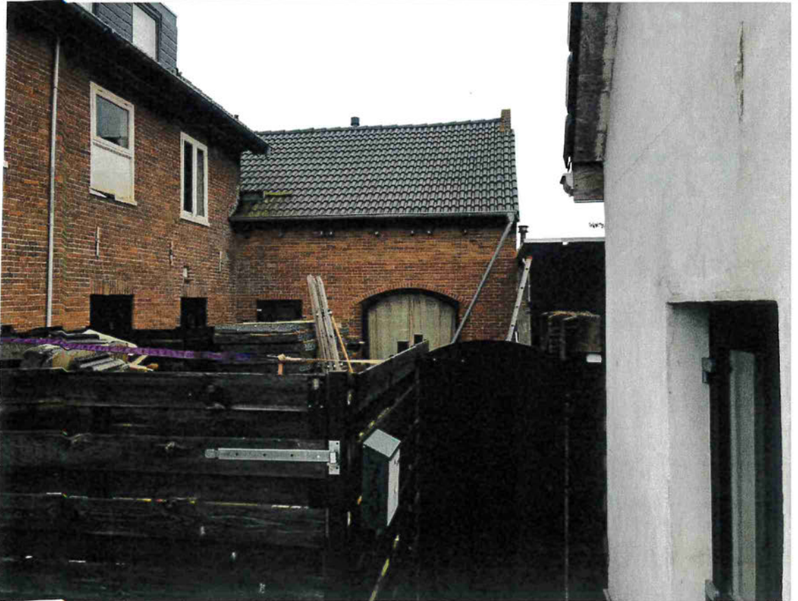
Naast de voordeur van nr. 73 is een poortdeur naar het achtererf. Tussen bijgebouw en nr. 73 is een doorgang gemaakt in de bestaande gemetselde muur, waardoor dit geen erfafscheiding meer is.
